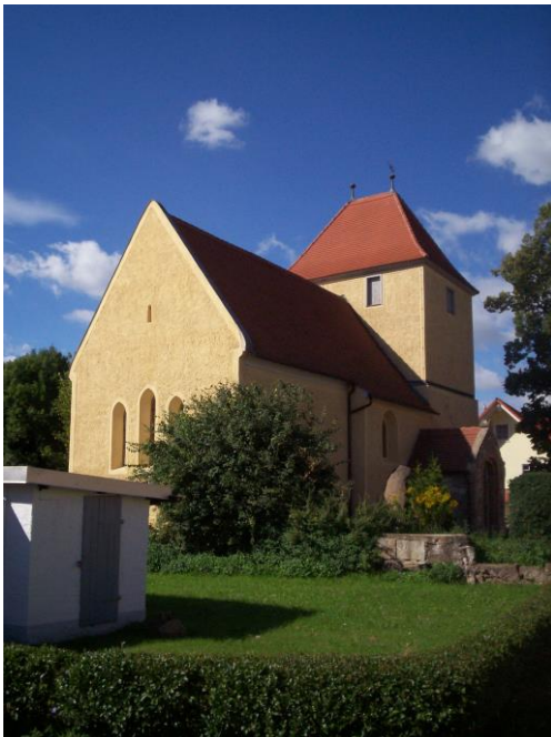
Spätromanische Kirche Seeben
