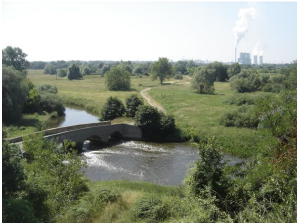
Schafbrücke über die Weiße Elster
