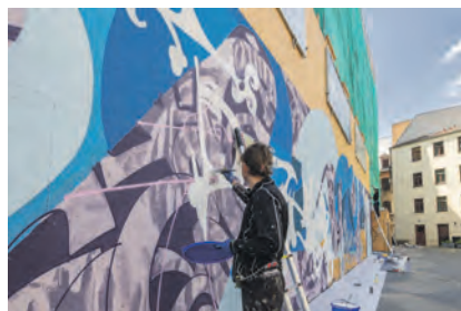
Ein Wandbild verschönert das Baugerüst.
