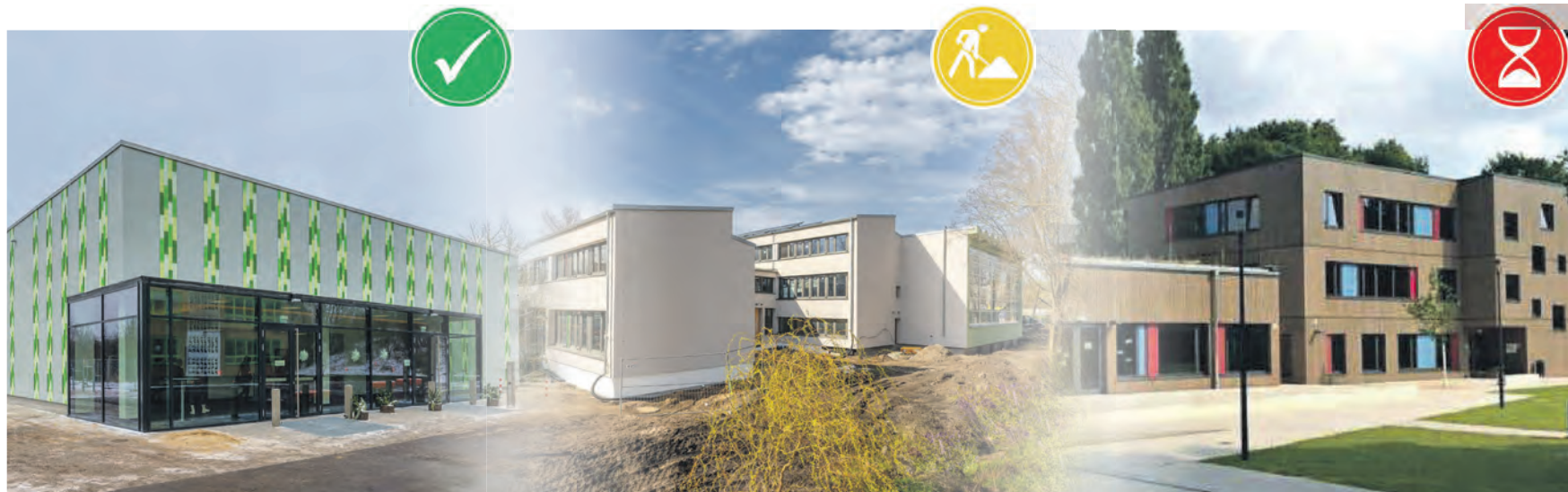
von links nach rechts: Die Marguerite-Friedlaender-Gesamtschule wurde umfassend saniert und hat zudem eine neue Aula erhalten. In der Grundschule Hans Christian Andersen laufen derzeit die letzten Arbeiten; sie kann ab dem neuen Schuljahr wieder genutzt werden. Der Erweiterungsbau für die Grundschule Büschdorf befindet sich noch in der Planung. Baustart soll im Oktober sein. Fotos: Thomas Ziegler / Fassadenentwurf: däscher architekten & ingenieure
