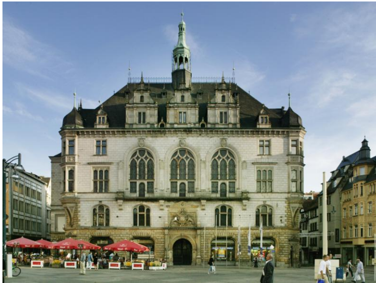
Abbildung 1 Fassade des Stadthauses vom Marktplatz aus
