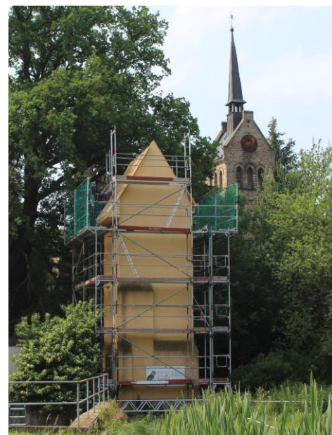
Eingerüsteter Trafoturm in Wils
